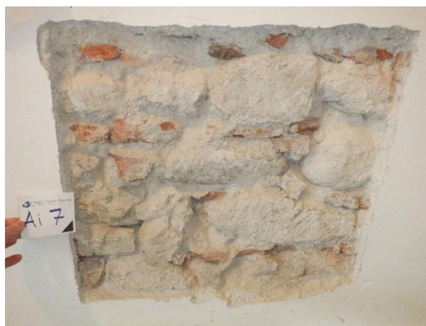
Asportazione di intonaco su parete ingresso posteriore
