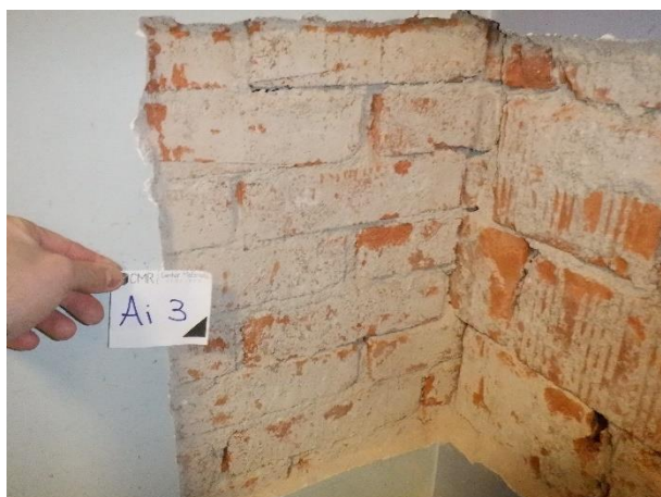
Asportazione di intonaco su spigolo interno: ampliamento corpo 4.
