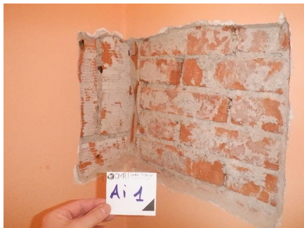
Asportazione di intonaco su interfaccia con ampliamento bagni.
