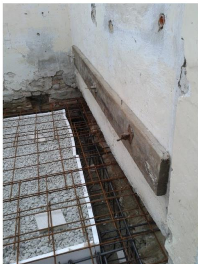
Immagine illustrativa consolidamento fondazioni
