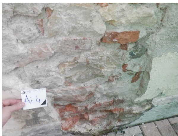
Asportazione di intonaco su parete esterna
