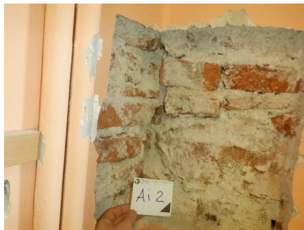
Asportazione di intonaco su spigolo interno zona aule piano terra.
