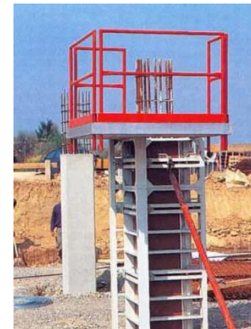
L'elevazione di murature e di pilastri in c.a. devono realizzate con postazioni munite di parapetto normale
