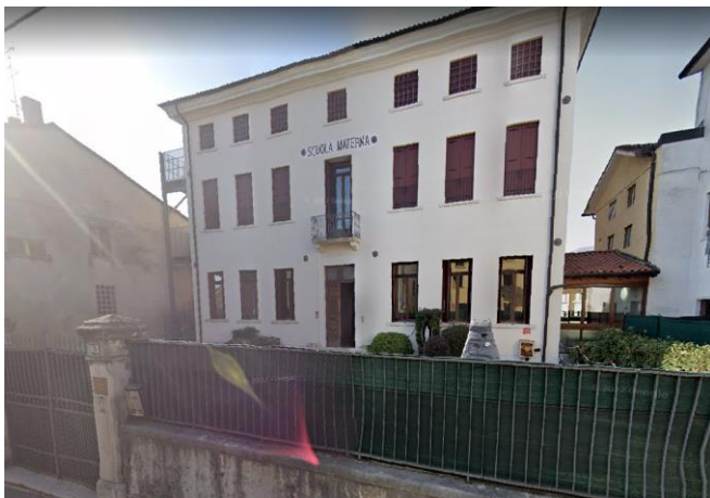
VISTA ESTERNA DA VIA RIGOBELLO
