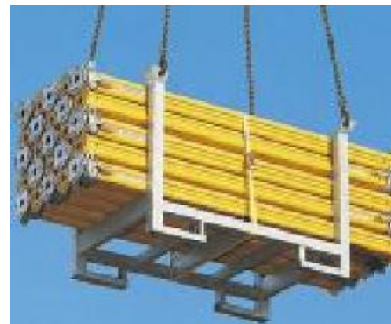
Il sollevamento tramite gru deve essere eseguito con idonea attrezzatura sottogancio
