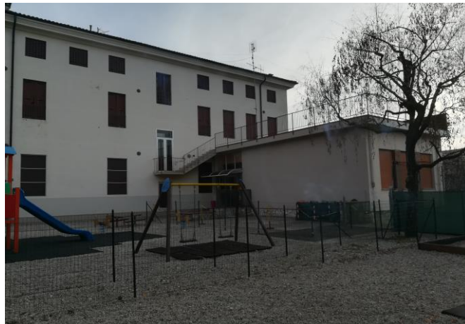
VISTA FACCIATA EST DAL CORTILE INTERNO
