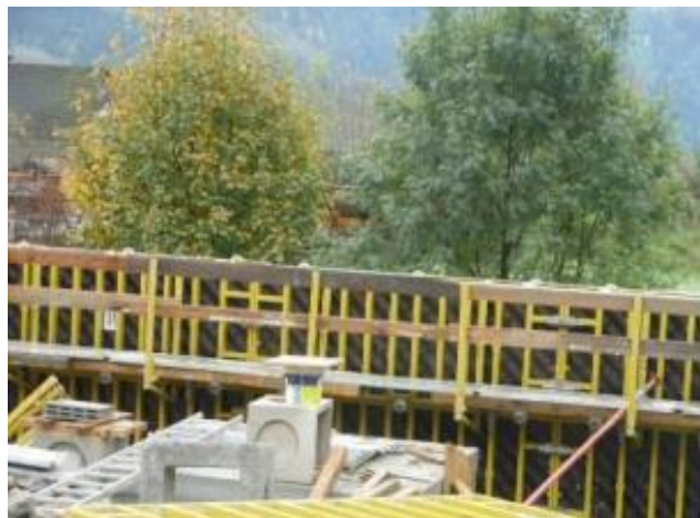
L'elevazione di murature e di pilastri in c.a. devono realizzate con postazioni munite di parapetto normale
