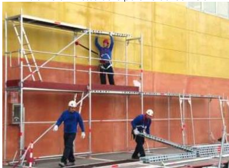
Durante le operazioni di montaggio del ponteggio deve essere utilizzato l'elmetto
