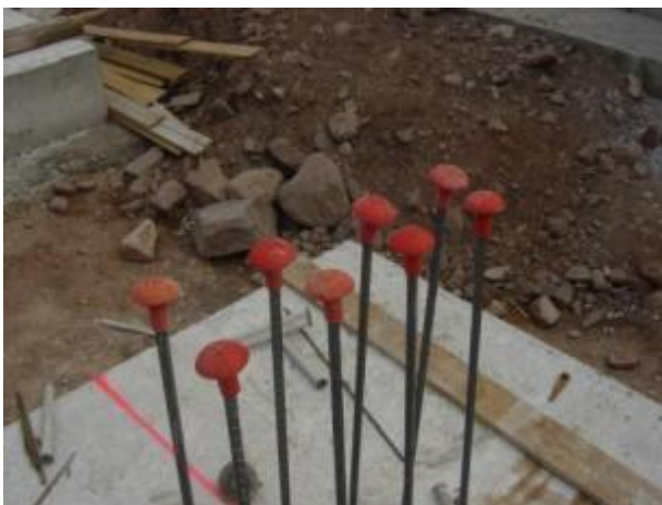
Le armature della platea devono essere protette con "funghi"
