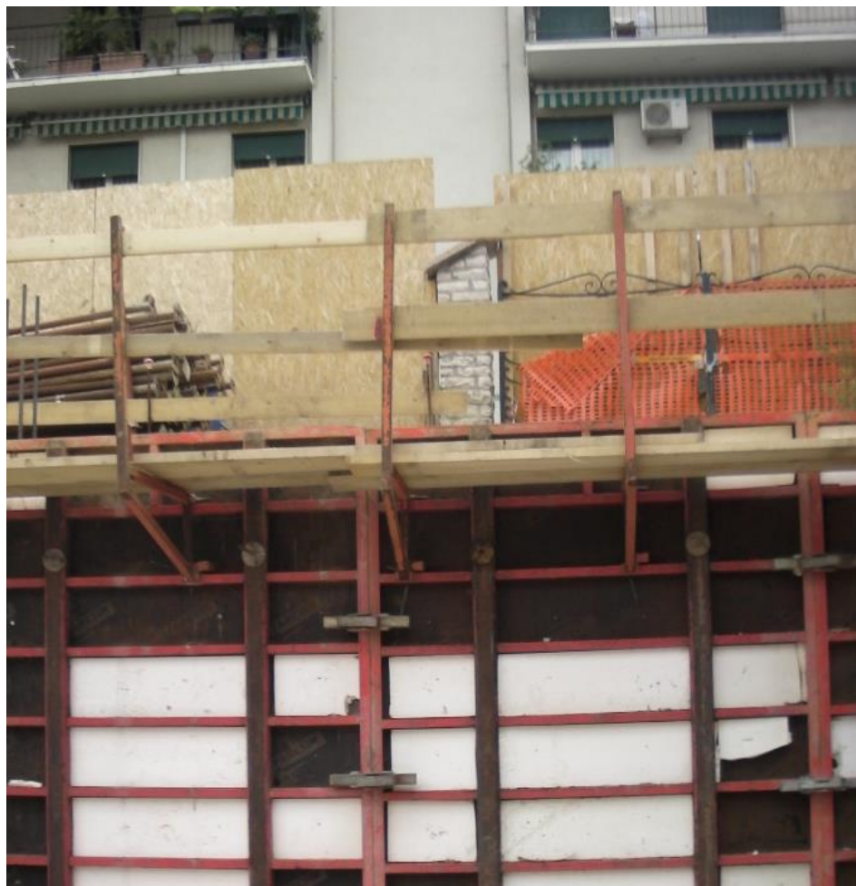
Accessori per la realizzazione di getti in c.a. in sicurezza
