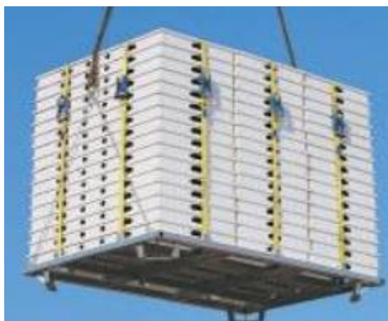
Il sollevamento tramite gru deve essere eseguito con idonea attrezzatura sottogancio
