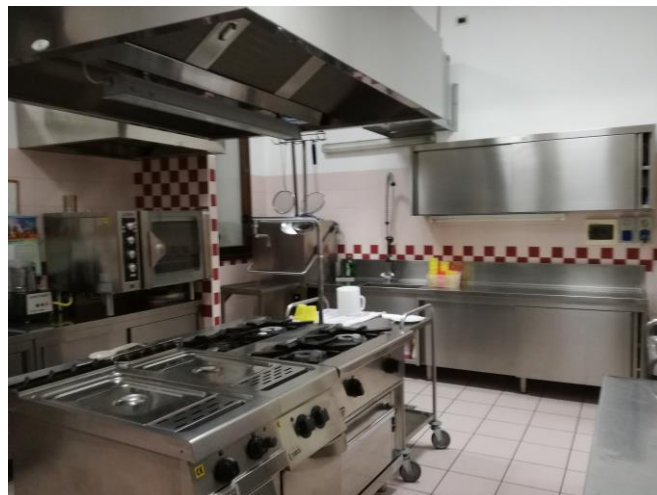
VISTA INTERNA CUCINA
