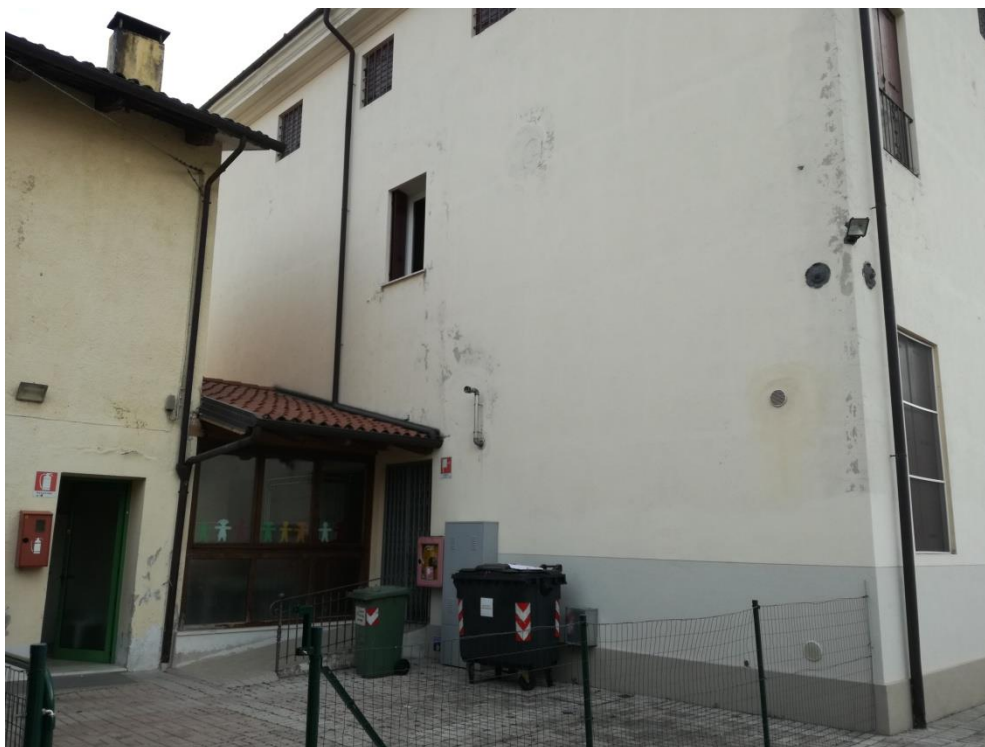
Foto 9: prospetto nord – ingresso secondario
