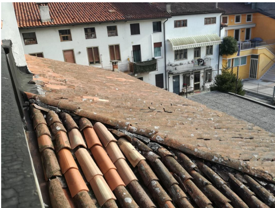
Foto 11: Copertura edificio adiacente all'ampliamento
