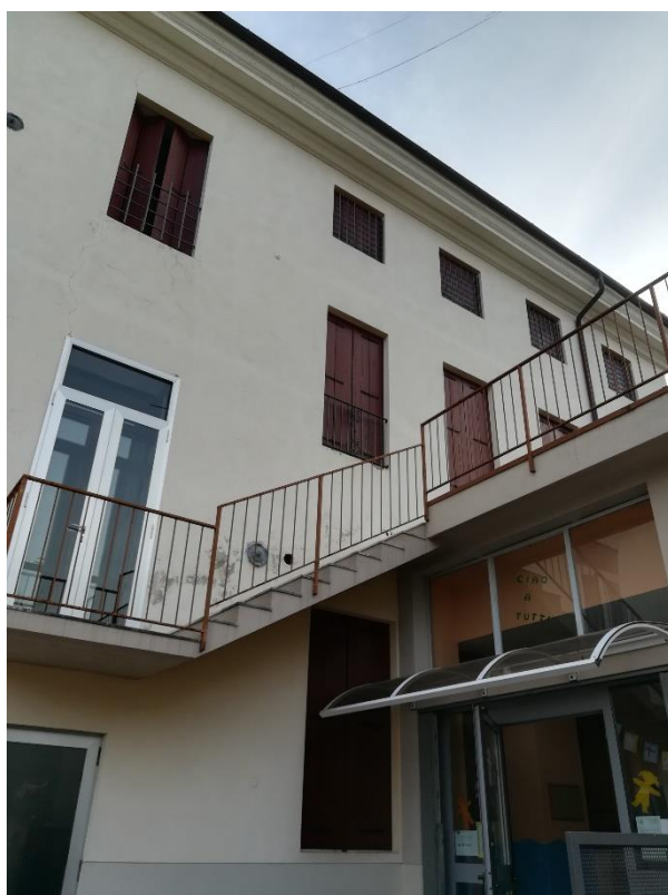
Foto 19: scala di accesso a tetto piano
