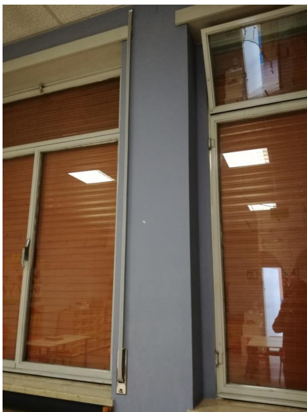
Foto 24: serramenti edificio ampliamento anni '70
