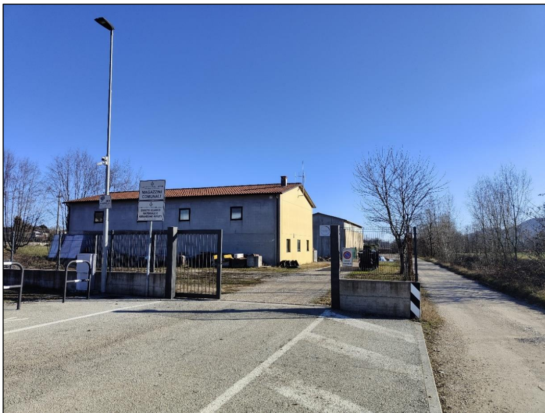
Figura 12: Strada di accesso all'ecocentro-stato di fatto
