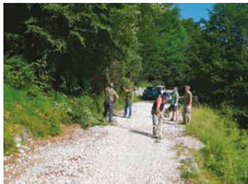
Manutenzione strada Scarubbi
